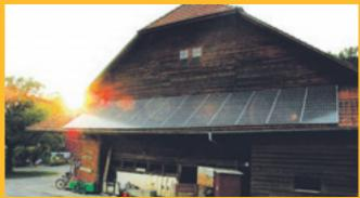
L'installation de **100 m<sup>2</sup> de panneaux solaires** photovoltaïques sur le toit de sa grange permet à cette famille d'agriculteurs de produire 8500 kWh par an.
